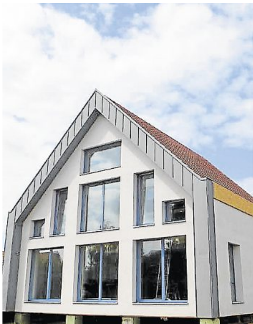
La première maison Europassive ne consomme que 12 kilowattheures par mètre carré et par an. Vincent Kempf, le patron de KMO, sur le toit de sa deuxième maison Europassive.
